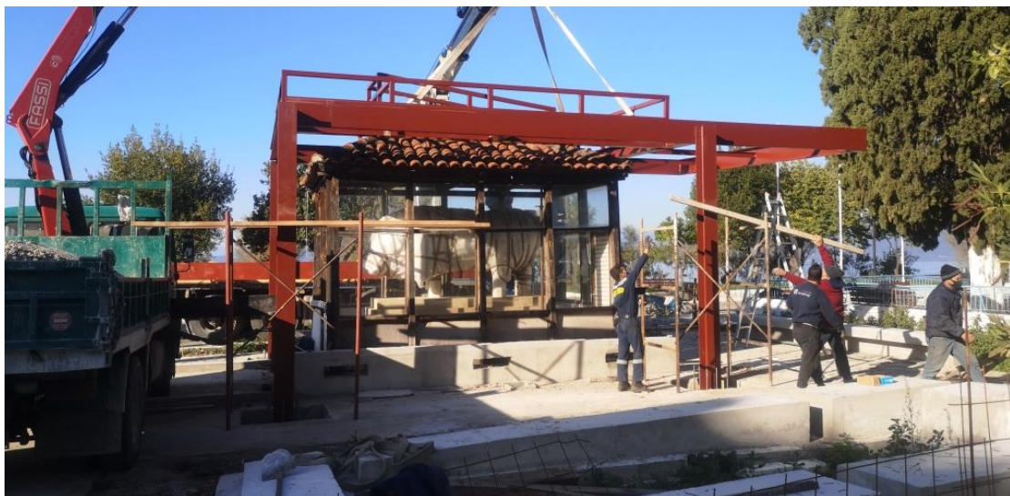
Κατά τη διάρκεια των εργασιών
