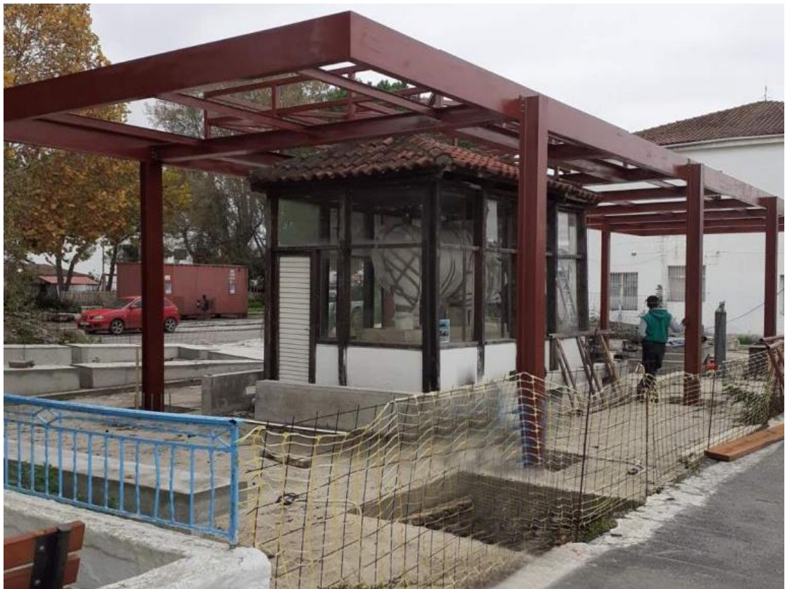
Κατά τη διάρκεια των εργασιών
